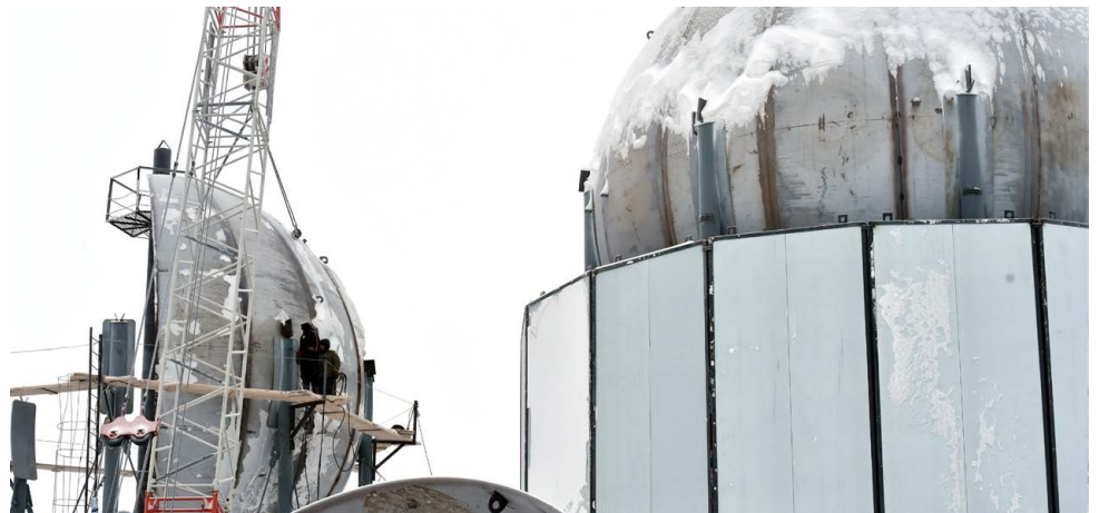
Так монтируются шаровые резервуары ГНС-2. Всего их будет шестнадцать
