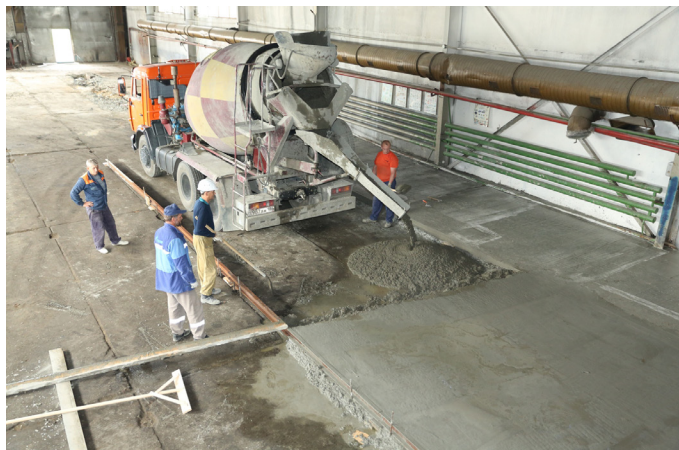
Юрий Гладык, Олег Ижурков, Павел Финаев выполняют бетонную подготовку покрытия пола бокса РМЦ
