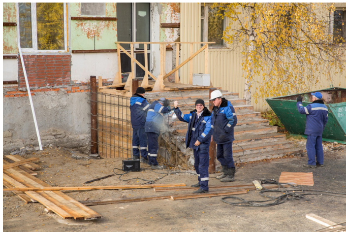
Андрей Савельев, Вячеслав Ерохин, Александр Орехов, Ильшат Гузаиров, Александр Филиппов ведут монтаж основания под навесной козырек входной группы
