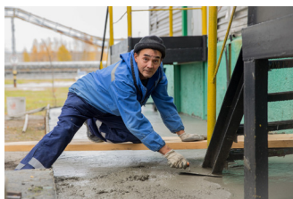
Олег Ижурков бетонирует отмостку (ШФЛУ-З)
